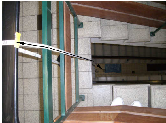
Abb. 6.9 Treppenhaus unserer Schule: Höhe 10m
